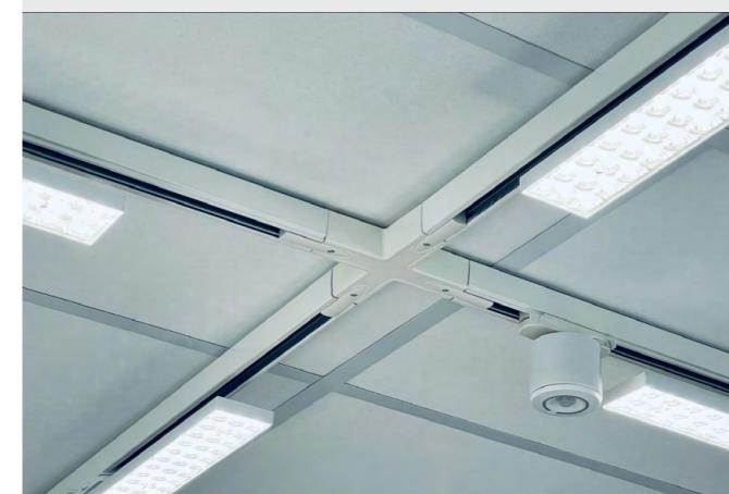
Los sensores del sistema DALI de la serie 32X son productos DALI Tracksensor listos para instalar. Los rieles de iluminación permiten una instalación fácil, flexible y segura del dispositivo en la posición deseada en el riel. Elija entre los siguientes sensores:
