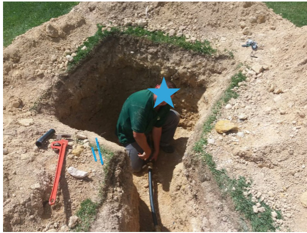
Figura 1. Reparación de fuga sin daños visibles, detectada en comunidad situada en Arenales del Sol – Elche, Alicante (Abril'18).
