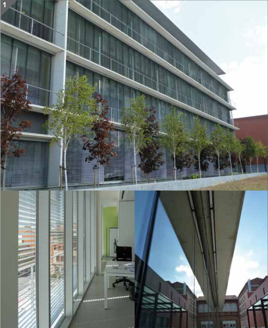
Fachada Dinámica. Ejemplo de rehabilitación energética con lama orientable motorizada.
