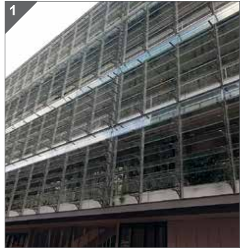
Sistema de ventilación automatizado.
