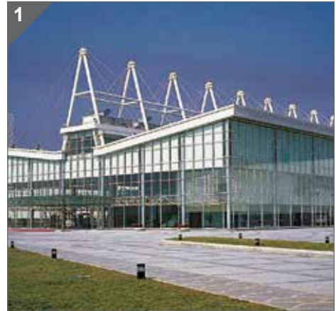
La iluminación natural en el sector industrial puede ser a través de lucernarios en cubierta.
