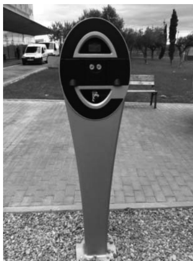
Figura 11. Punto recargar vehículo eléctrico.
