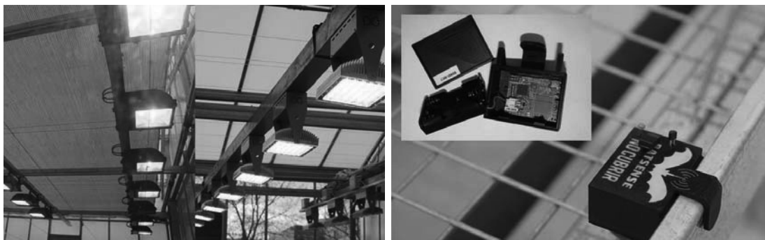
Figura 3. Sistema de iluminación. Izda: Sistema de luminarias LED frente al antiguo. Dcha: BatSense adaptado para el monitoreo de invernaderos.
