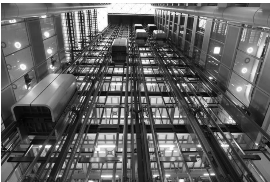
Figura 1. Instalación de ascensores TWIN en St Botolphs (Reino Unido).
