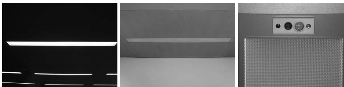
Figura 2. Luminarias Philips con tecnología PoE instaladas en Torre Europa.
