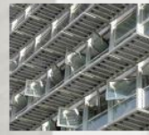
Integración de los paneles fotovoltaicos en la fachada. Fuente: "Arquitectos Hombre de Piedra, Montemálaga".
