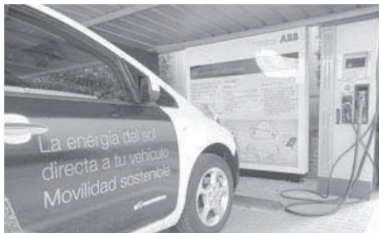
Figura 5. Instalación de carga rápida de vehículo eléctrico.
