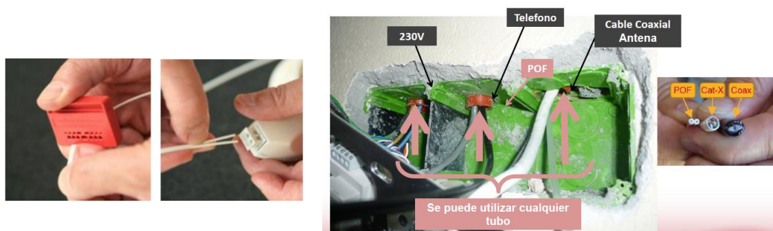
Figura 3. Facilidad de instalación sin conectores y utilizando cualquier conducto existente
