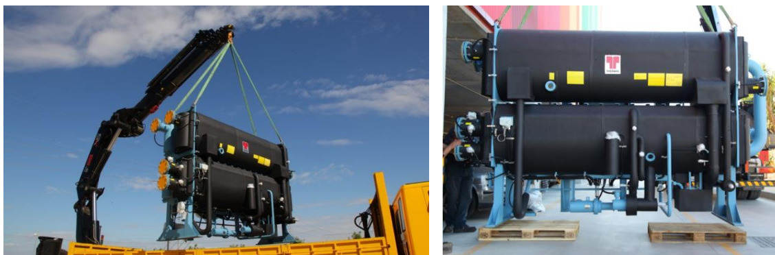
Figura 2. Sistema de refrigeración por máquina de absorción (Thermax LT10). Recepción de equipos.
