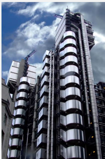
Edificio Lloyds (LONDRES)
