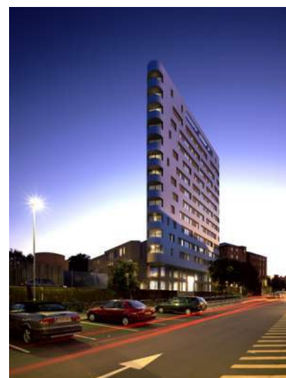
Edificio sostenible en Londres Fuente: www.elsingular.com
