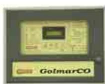
**Central Microprocesada de monóxido de carbono, 2 zonas con capacidad máxima de 22 detectores por zona**
