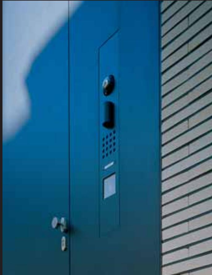
El nivel de montaje se sitúa a tal profundidad que la placa queda perfectamente enrasada con la superficie colindante. Únicamente sobresale algún elemento cuando alguna función así lo requiera; por ejemplo, en el caso de la videocámara y del foco LED. La instalación reflejada en la imagen, al igual que el panel que rodea a la puerta, cuenta con un revestimiento de Duraflon, material extremadamente resistente de por sí y resistente, además, a la suciedad.
