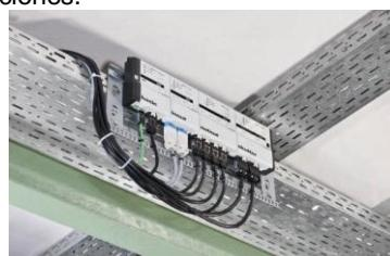
Como sistema de instalación compacto, está formado por módulos planos que permiten su integración en todo tipo de instalación (suelo técnico, paredes huecas, techo registrable), tanto en edificios nuevos como renovados.
