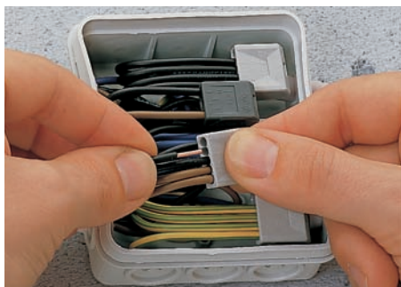
Conexión: Introducir el conductor pelado hasta el fondo
