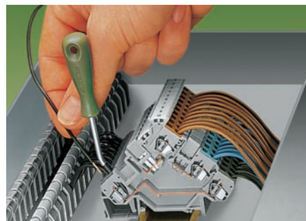
Los destornilladores mencionados arriba son particularmente apropiados para el accionamiento de bornas para sensores y actuadores con cableado frontal, serie 280, gracias a sus dimensiones de hoja según DIN 5264.
