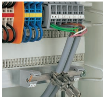
Montaje sobre barra común de neutro con soportes
